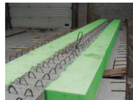
Herstellung von Deckenelementen entsprechend der Planungen der Domostatik GmbH
